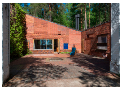
Muuratsalo Experimentalhaus Foto Maija Holma, Alvar Aalto Stiftung
